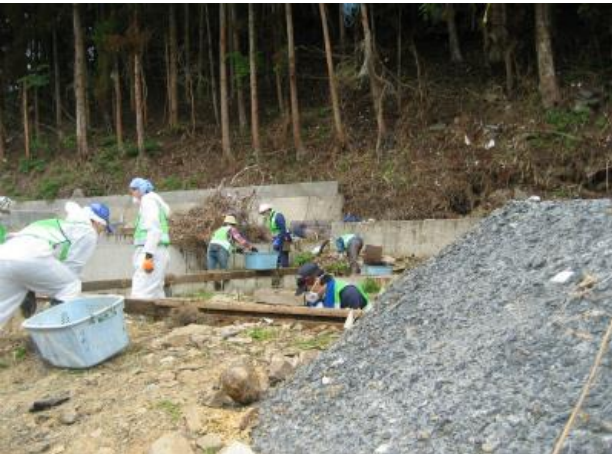
個人宅の瓦礫の撤去作業
