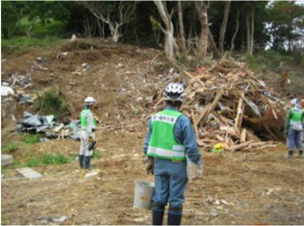
津波により、がれきが山に残っているため、片付けを行いました。
