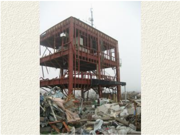
津波の無残な爪跡を残す南三陸町防災対策庁舎。
