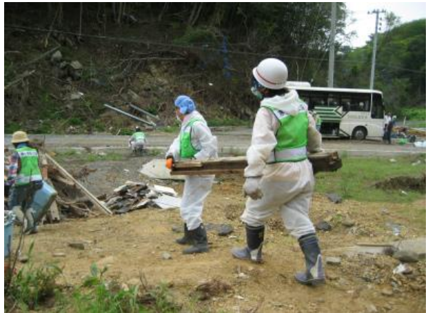
重い柱は2人で運びます。安全第一！
